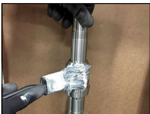
Obrázek 152 - Použijte prostředek proti „srůstání“ závitů
