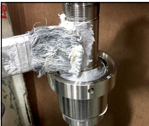
Abbildung 161 - Auftragen von Gleitmittel auf die Welle
