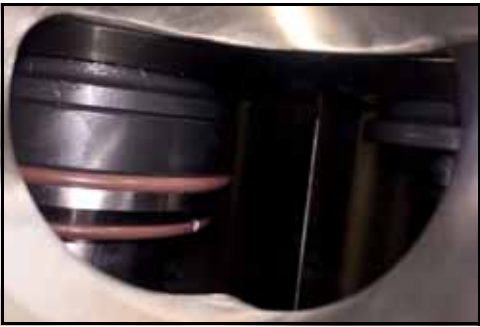
Bild 105 – Vy genom pumphusets öppning
