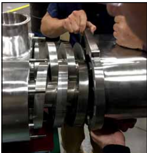
Bild 129 – 220-UTS Montering av pumphölje
